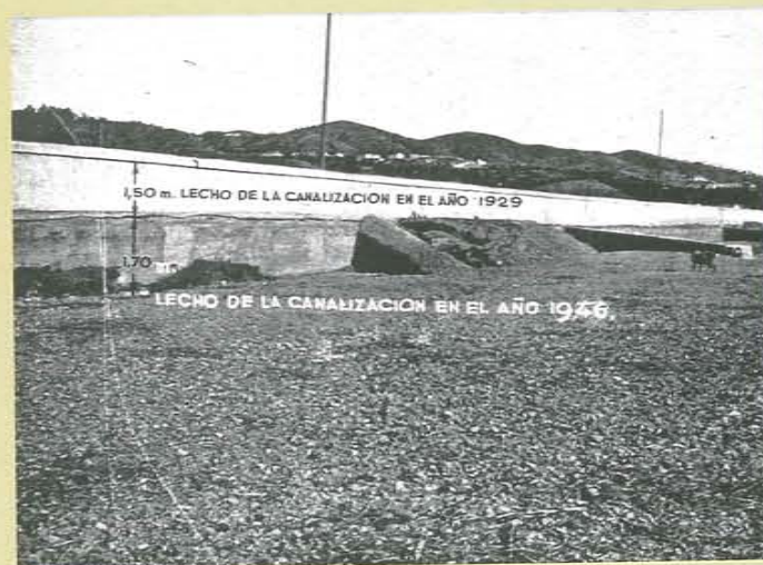
Descenso de 1,70 metros en la canalización.
