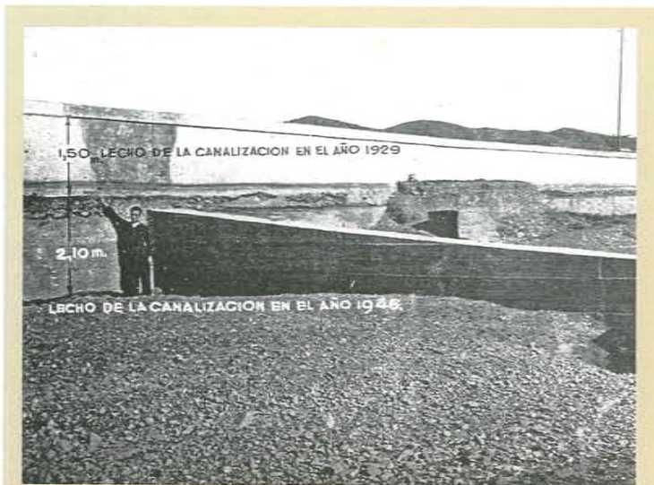
Descenso de 2,10 metros. Obsérvese en el prisma que queda a la derecha el fenómeno contrario de haberse ido rellenando cuando lo construyeron.
